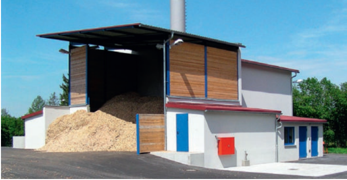
Biomasseheizwerk der Stadtwerke Bad Windsheim
