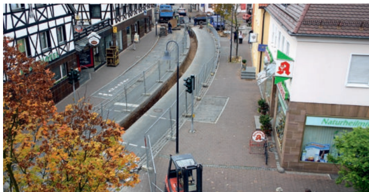
Bau der Nahwärmetrasse im Ortskern von Adelsdorf
