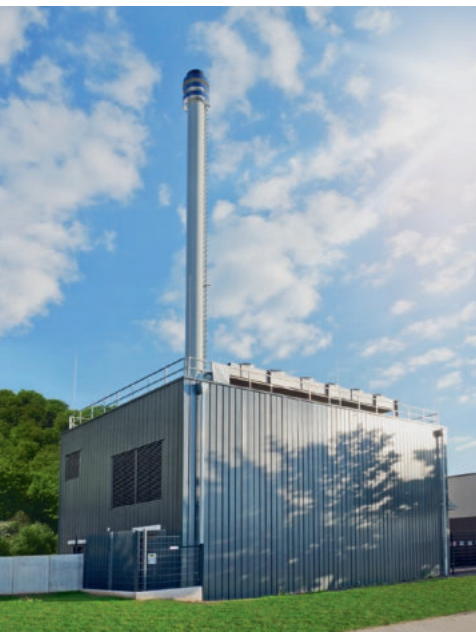
In einem Blockheizkraftwerk werden Wärme und Strom gleichzeitig erzeugt.
